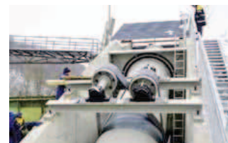
Widok na pasy nośne oraz uszczelnienie od strony wody górnej
